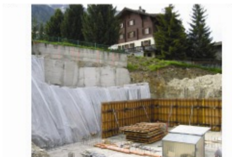
Wandschalung Keller und Unterfangung
